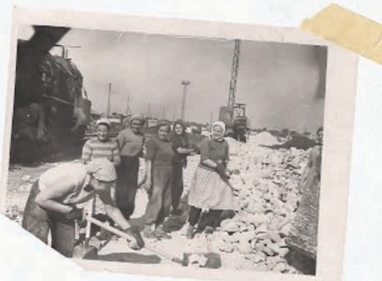
Будаўніцтва цукровага завода ў Гарадзеі
